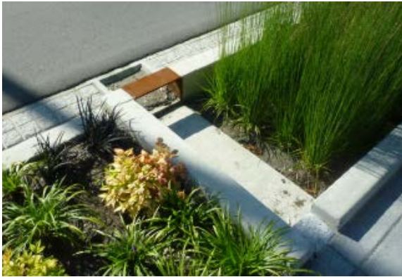
Bild 3. Regnbäddar liknar naturens egna sätt att med hjälp av fysiska, kemiska och biologiska processer omhänderta dagvattnet.
