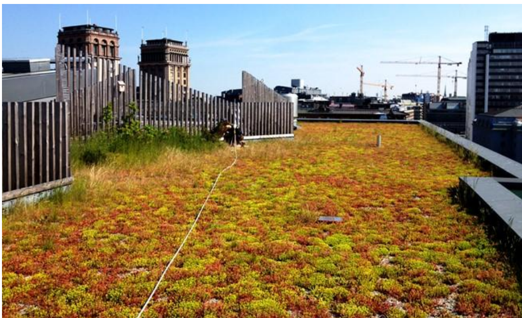
Figur 14. Exempel på utformning av grönt tak, Dagvattenguiden.
