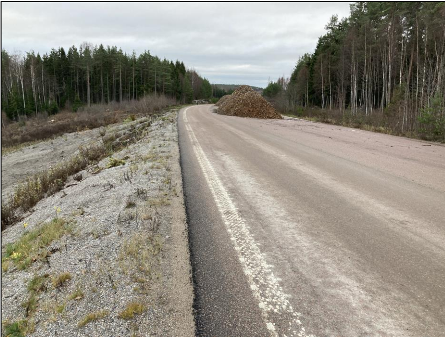
Figur 2. Bild tagen längs den gamla E4:an i riktning söderut. Till vänster i bild, dvs öster om vägkroppen skymtar en slänt som vintertid fungerar som en av kommunens snötippor.
