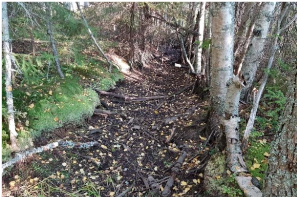
Figur 6. Vattendrag/grävt dike inom planområdet. Diket är inte vattenförande året om. Källa: Hudiksvalls kommun.
